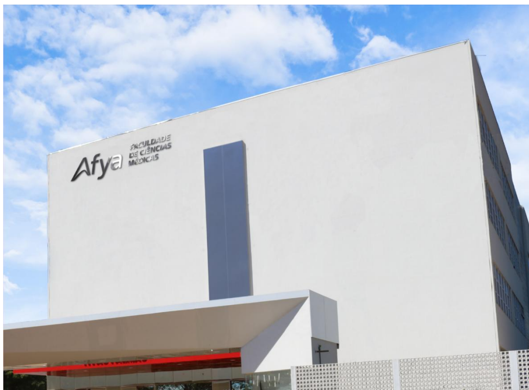
Figura 60 - Fachada do prédio de aulas
