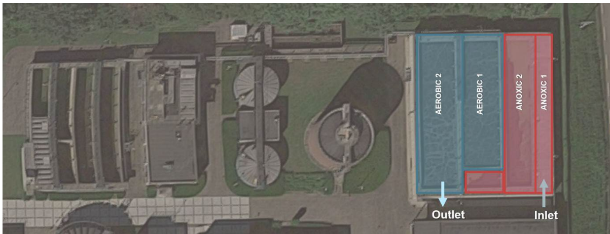
Abbildung 1: Aufbau und Konfiguration der untersuchten industriellen Abwasserbehandlungsanlage. Das Abwasser hat kommunale Eigenschaften, ist jedoch hochdynamisch und weist eine recht hohe Ammoniakbelastung auf.
