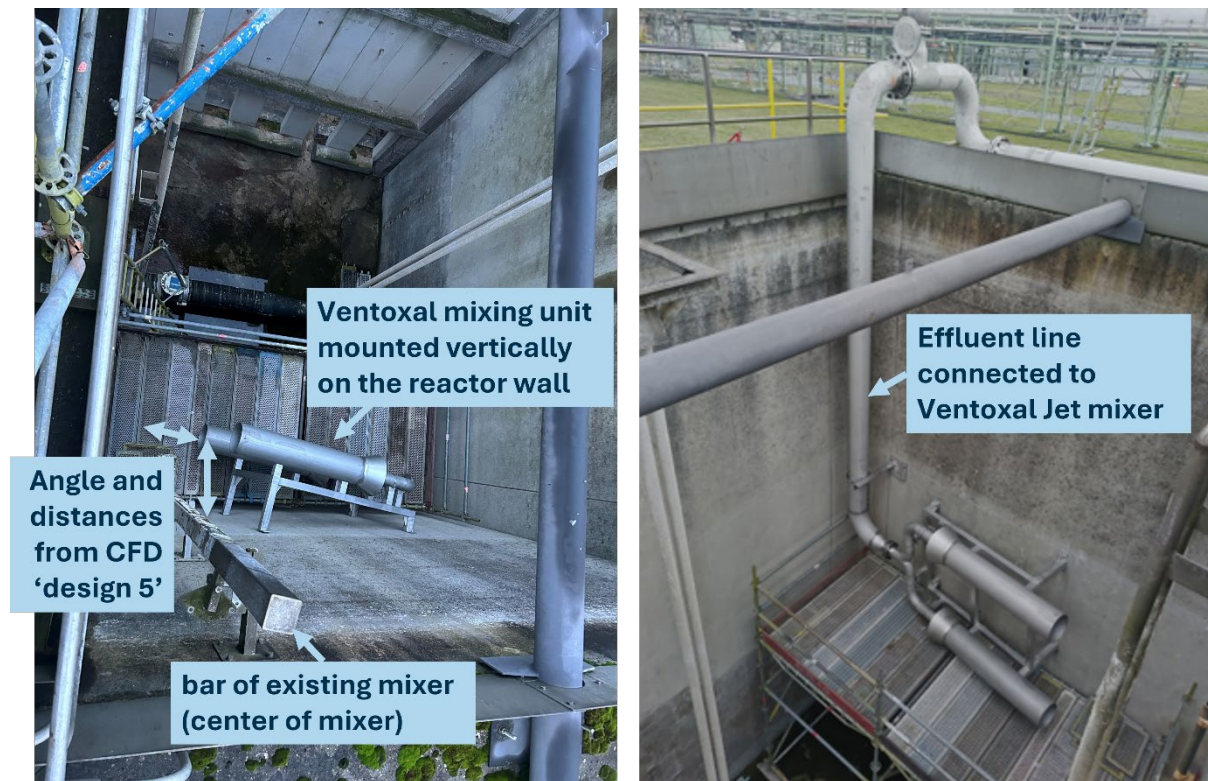
Figura 6: Las unidades de mezcla Ventoxal se colocaron conforme al escenario CFD más favorable. Se esperaba que este diseño, con una disposición vertical específica de las unidades de mezcla, generase una toxicidad por pH bajo mínima.
