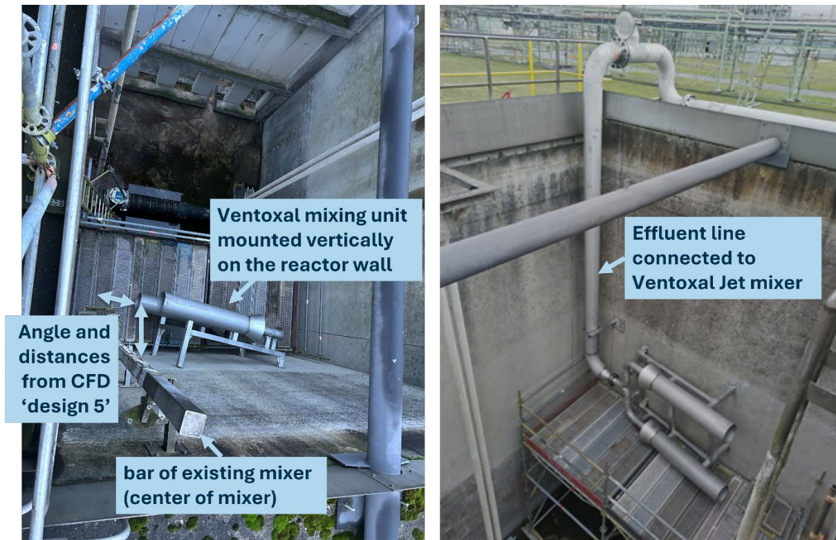
Abbildung 6: Die Ventoxal-Mischeinheiten wurden gemäß dem optimalen CFD-Szenario platziert. Von dieser Auslegung mit einer spezifischen vertikalen Platzierung der Mischeinheiten wurde eine minimale Niedrig-pH-Toxizität erwartet.
