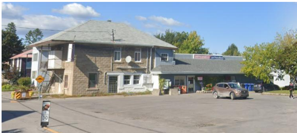
Figure 4 dépanneur aux abords de la rue Centrale
