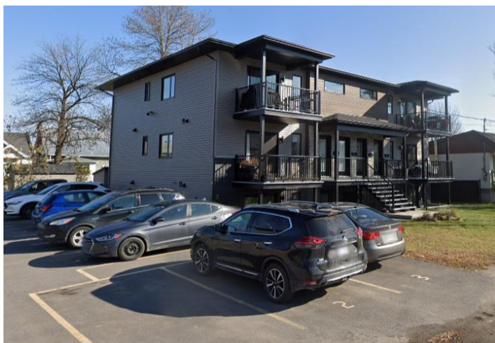
Figure 3 Habitation multifamiliale sur la rue de Montigny
