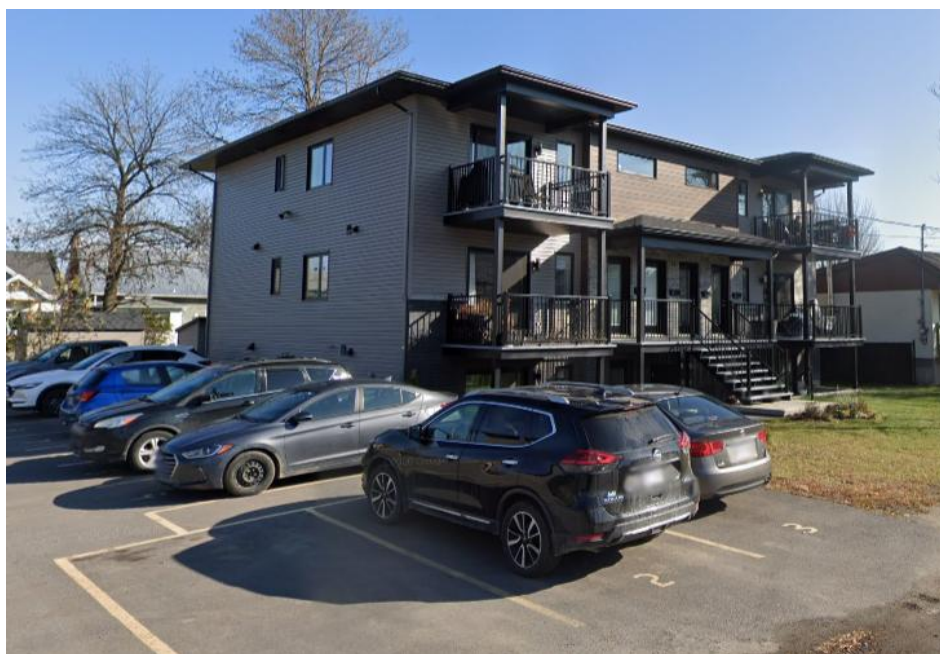
Figure 3 Habitation multifamiliale sur la rue de Montigny
