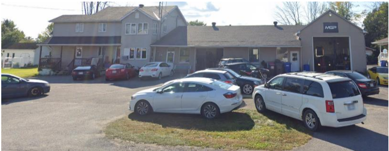
Figure 5 Garage aux abords du boulevard de Soulanges
