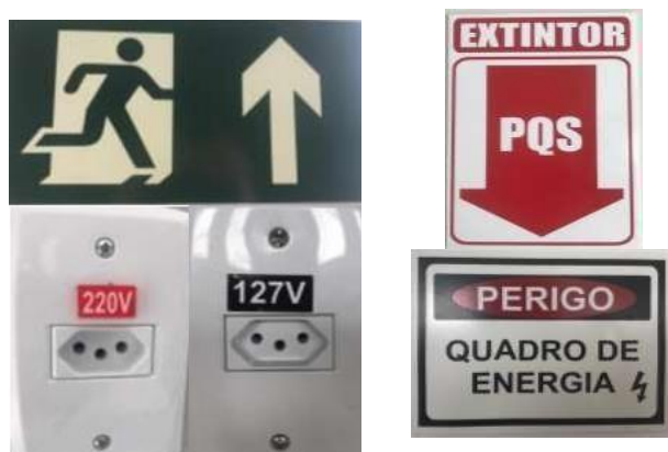
Figura 6: Avisos e sinalizações – EPC
