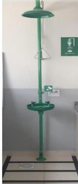
Figura 07: Chuveiro de Emergência e Lava olhos – Laboratório Multifuncional II
