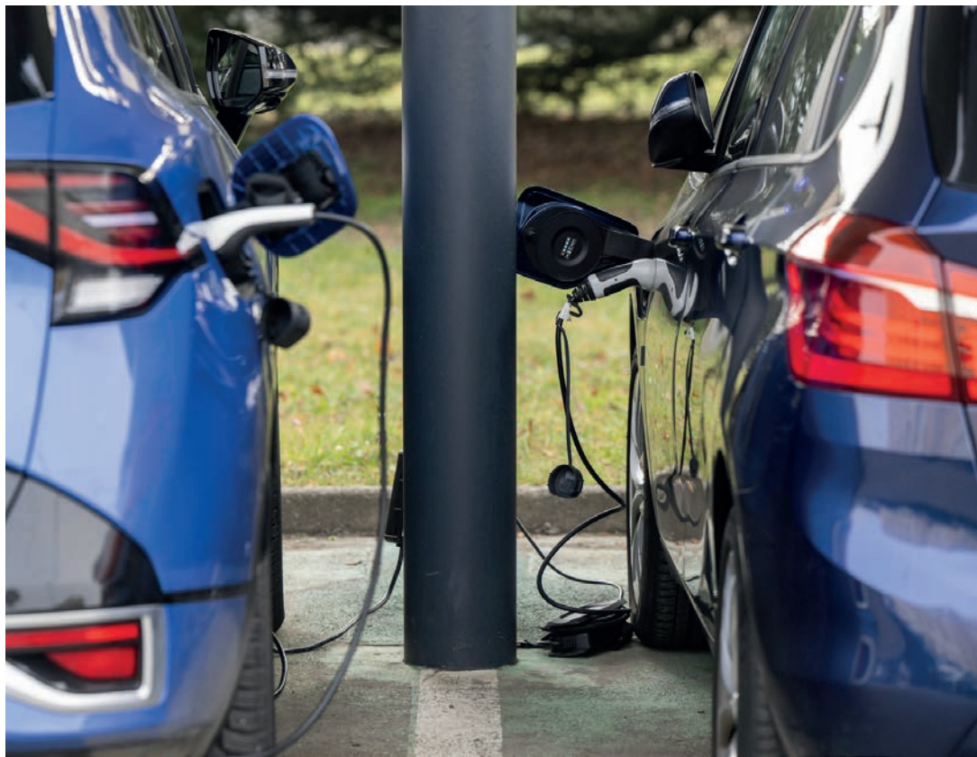
Zwei Elektroautos laden an einer Station ihre Batterien auf.
