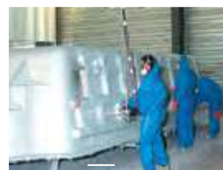
Pose des renforts + résine de protection
