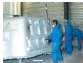
Pose des renforts + résine de protection
