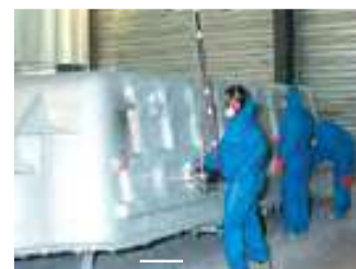
Pose des renforts + résine de protection
