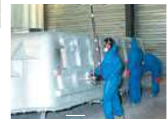
Pose des renforts + résine de protection
