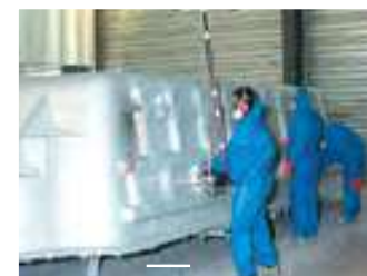
Pose des renforts + résine de protection
