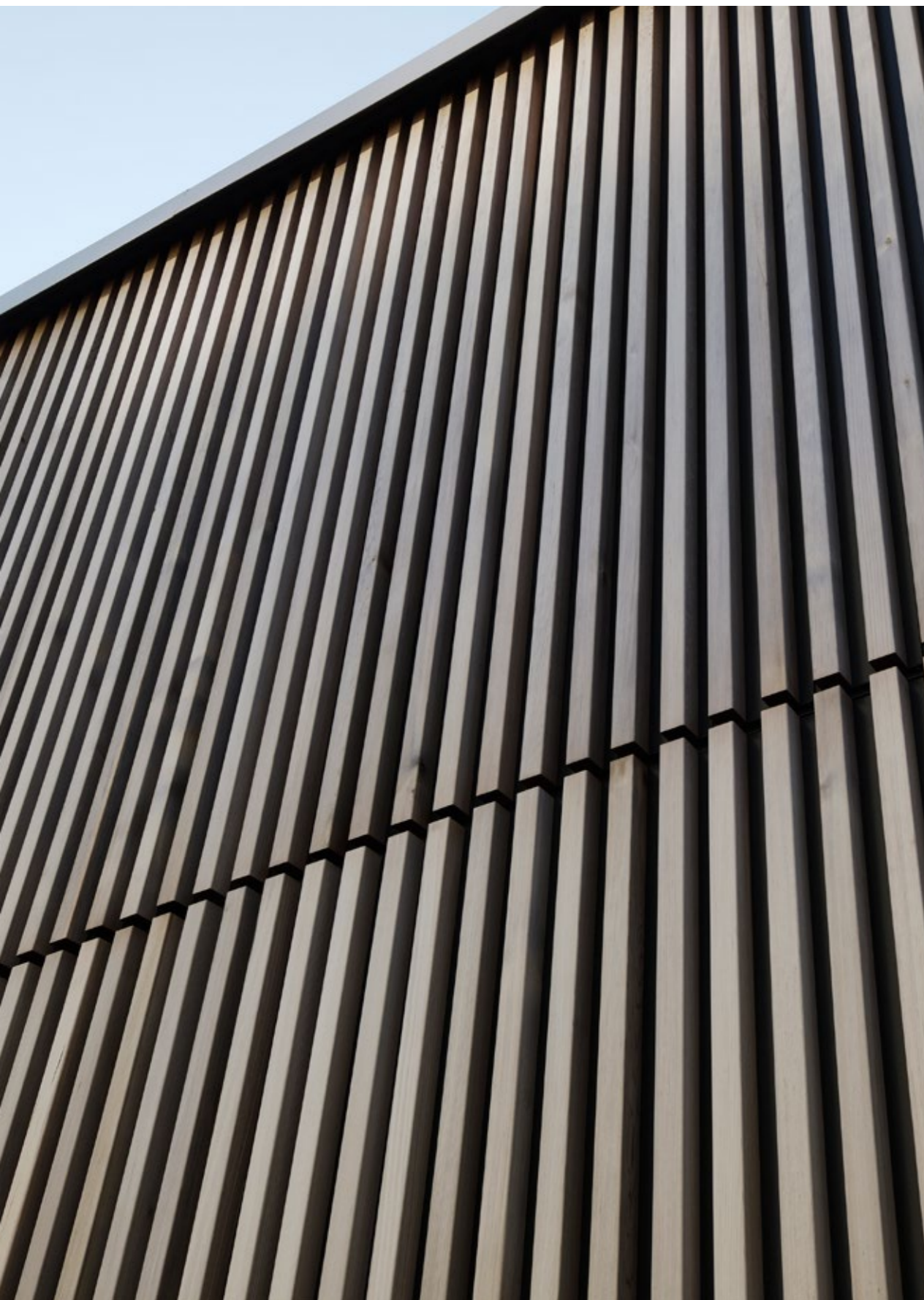
Rigshospitalet Glostrup, Krankenhaus, Woodfac Panel
