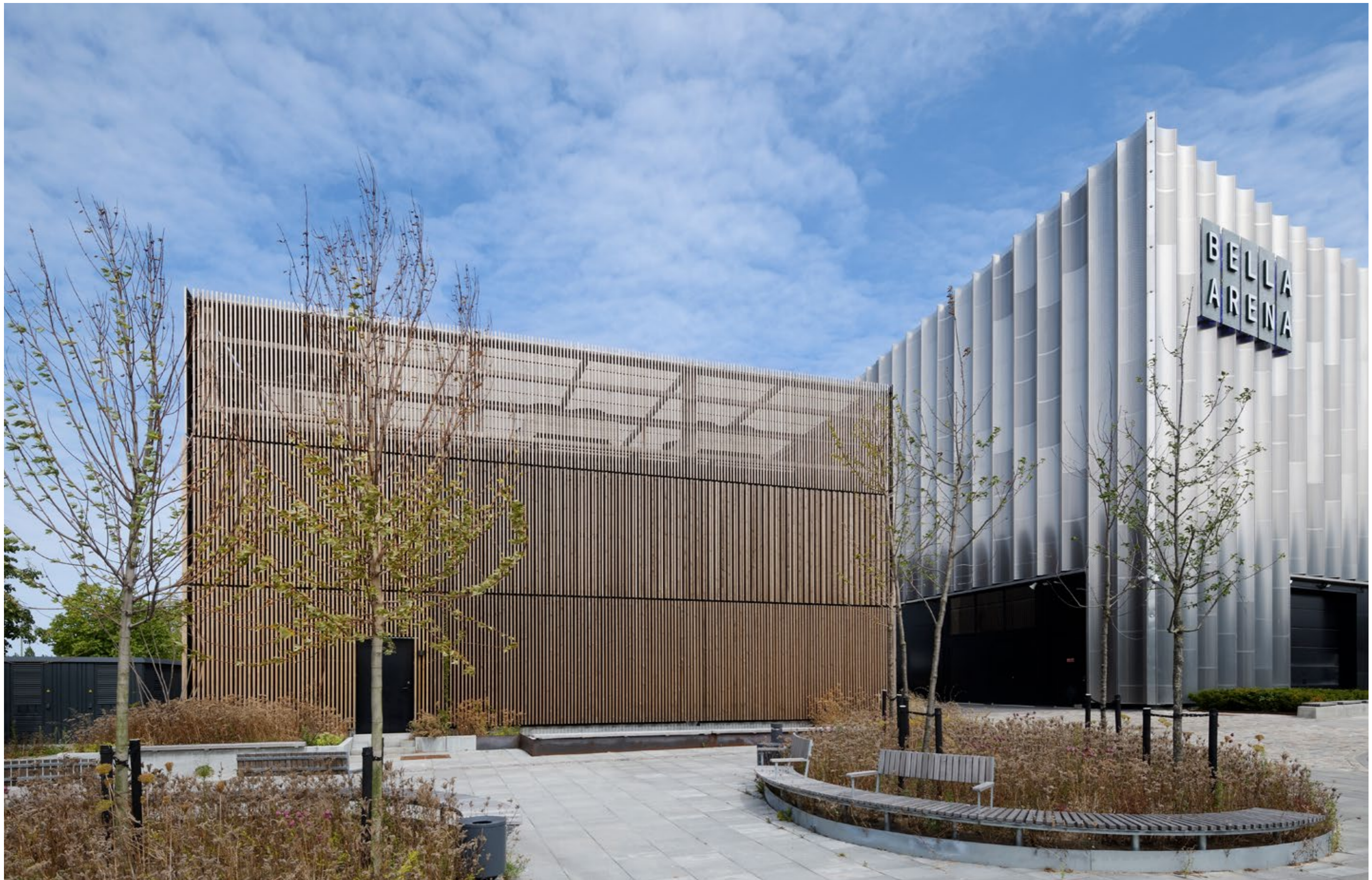
Bella Center, Verkleidung technischer Gebäudeausstattung, Woodfac Click
