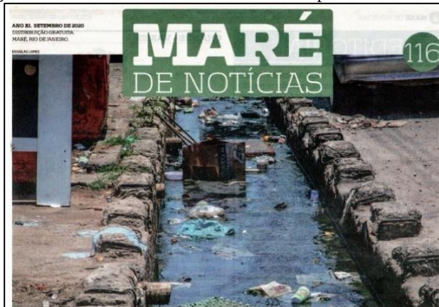
Figura 81 – Canal a céu aberto – falta de limpeza e assoreamento
