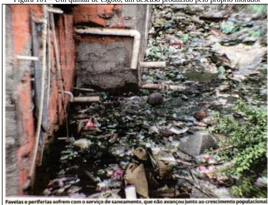
Figura 101 – Um quintal de esgoto, um descaso produzido pelo próprio morador
