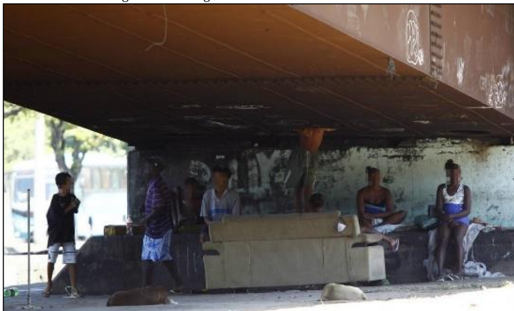
Figura 11– Passagem sob o Viaduto da Linha Amarela.
