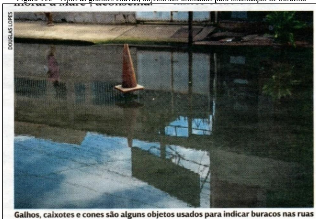
Figura 100 – Após as grandes chuvas, objetos são utilizados para sinalização de buracos.
