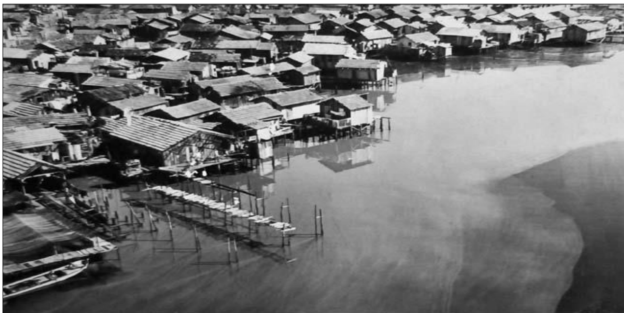
Figura 6– Primeiros registros da Praia extinta do Apicu, década de 1940.
