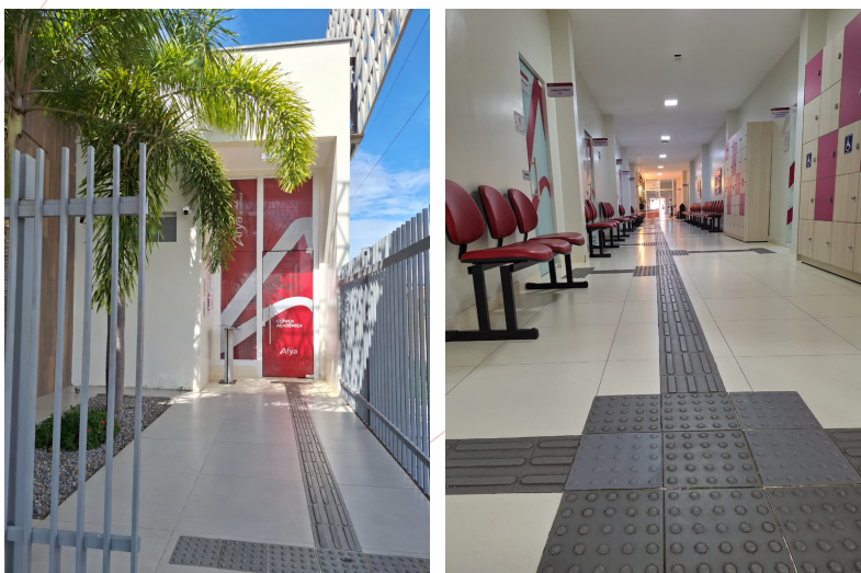
Imagem 02: piso tátil da entrada da clínica até a entrada de todos os consultórios
