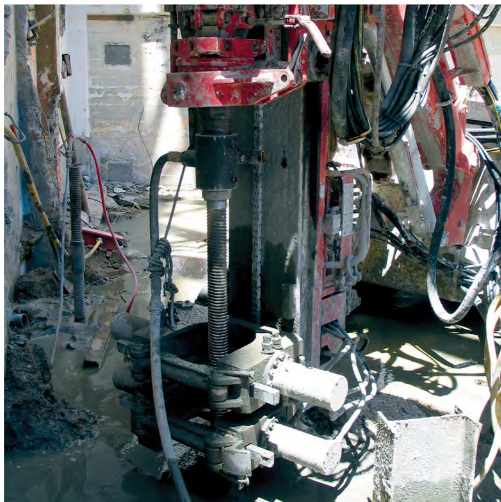
Perforación y Grout Simultáneos
