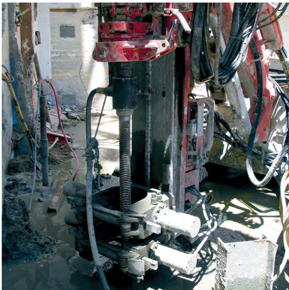
Perforación y Grout Simultáneos
