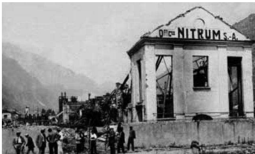
32 Esplosione delle Officine Nitrum a Bodio, 21 luglio 1921
