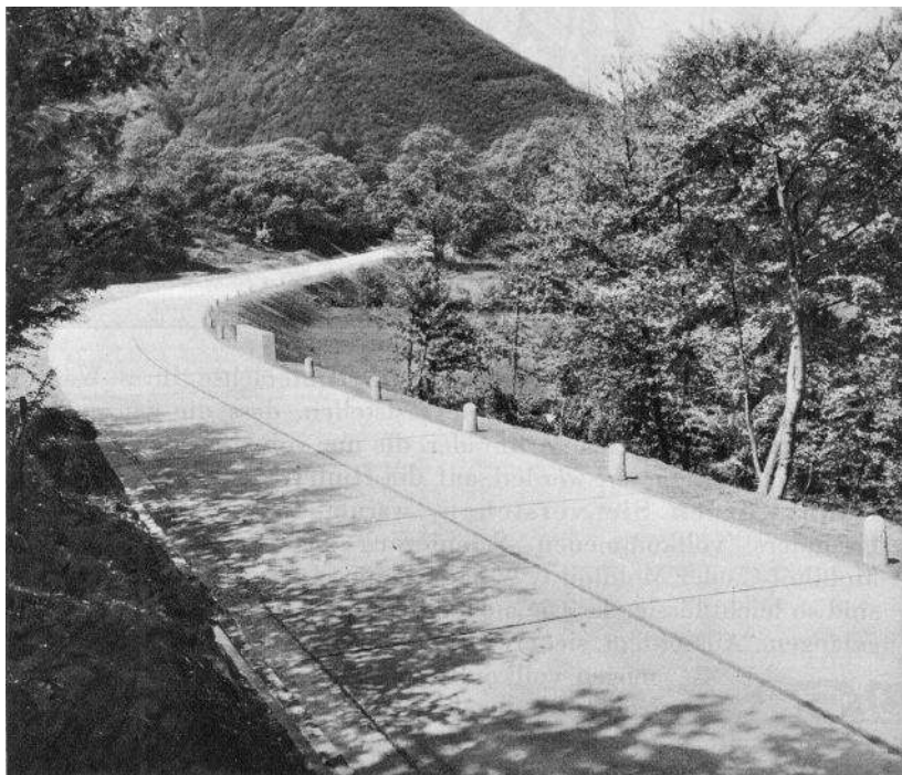
60 1931: lato nord del Monte Ceneri in beton
