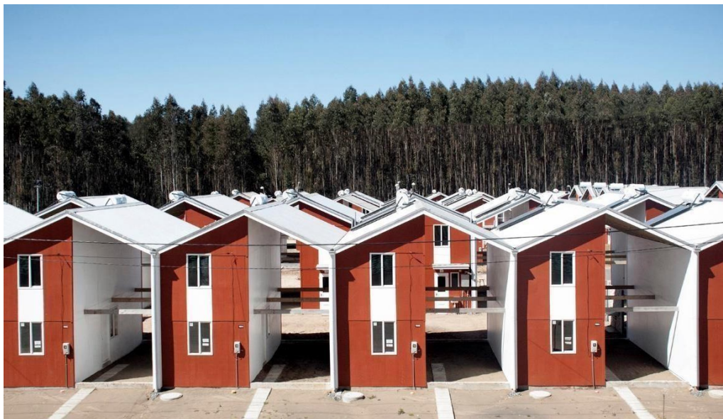
Figura 7 - Fachada do Projeto Villa Verde 2016
