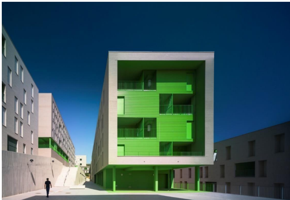
Figura 2 - Fachada do Projeto SV60
