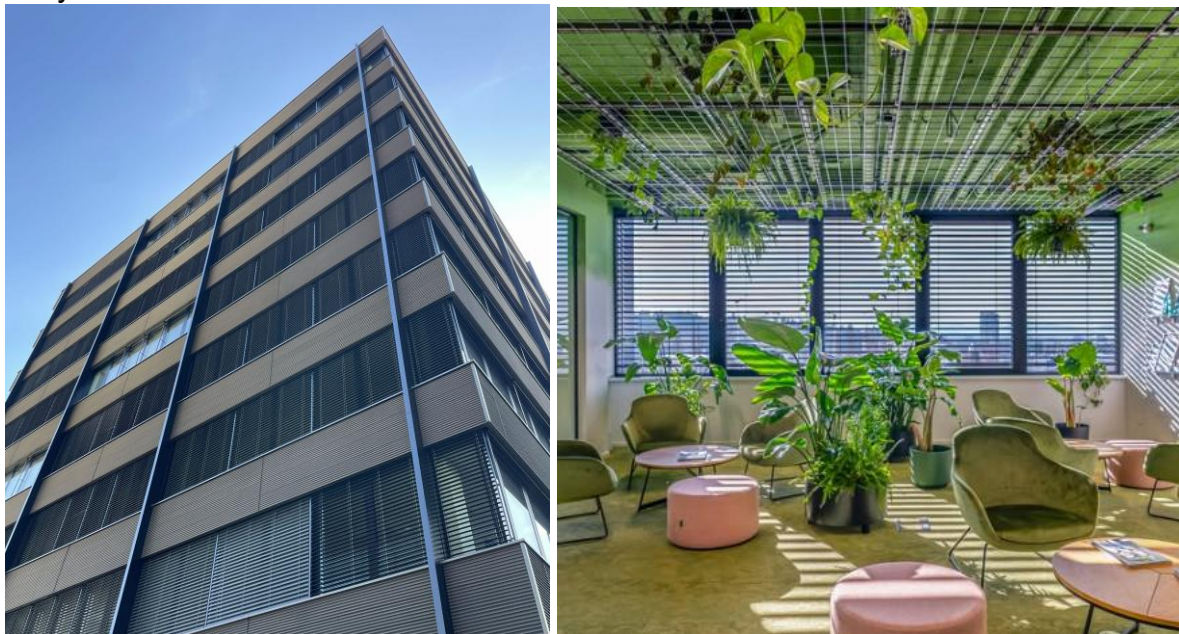
Manuálne ovládateľné tienenie na fasáde budovy, pohľad z interiéru priestorov firmy BeLenka.
