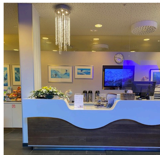
En nedsenket del av resepsjonsdisken som er beregnet for rullestolbrukere, barn, kortvokste mv. bør ikke benyttes til brosjyrer, aviser, mv.
