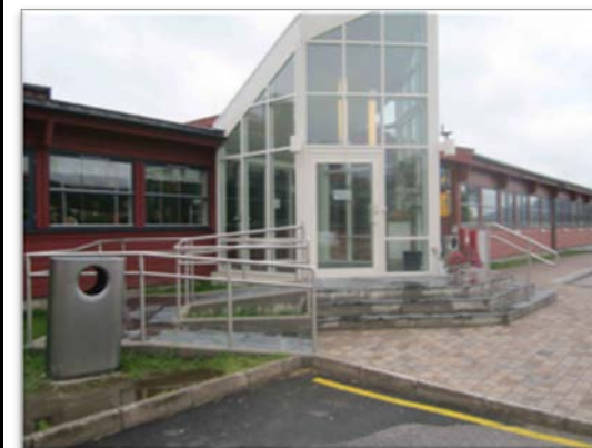
Godt synlig inngangsparti med trapp og rampe, med håndløpere på begge sider i to høyder.
