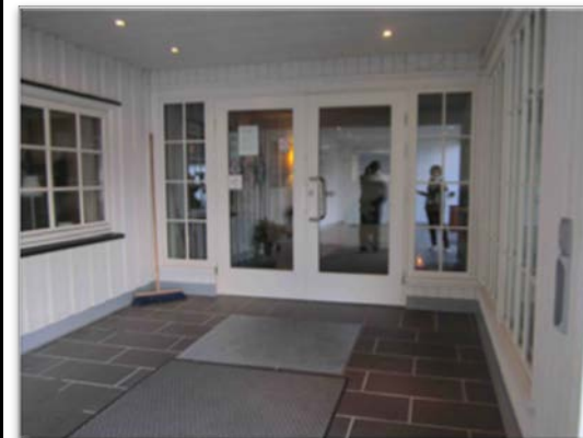
Inngang på samme nivå som uteareal uten nivåforskjell. Betjeningsknapp for automatisk døråpning. Gangbane som er synlig og taktil til inngangsdør
