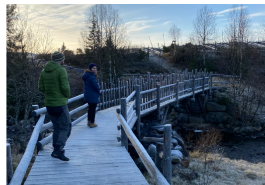
Gangbru med god bredde, og med stoppkant og rekkverk på begge sider.
