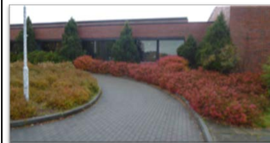
Godt synlig og taktil avgrensning av gangbane til inngang. En godt synlig og følbare kant mellom asfalt/grus og gress er tilstrekkelig.
