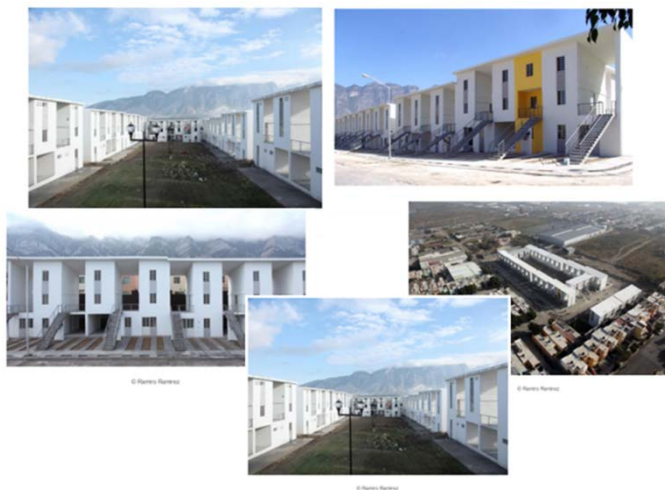
Figura 32: Imagens gerais do conjunto.
