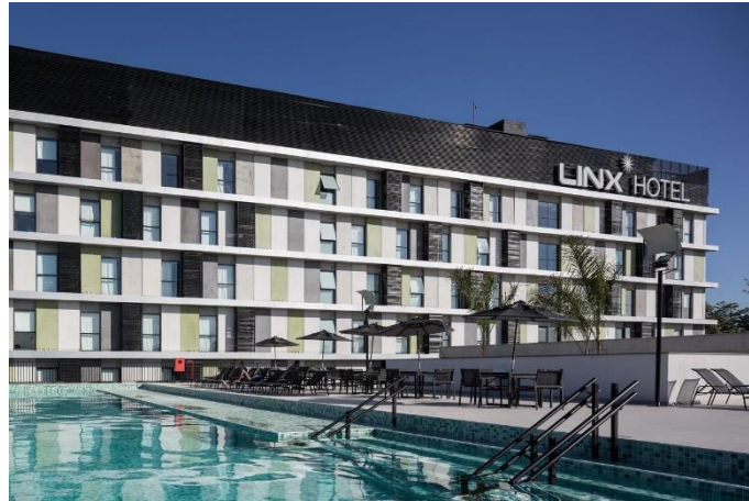
Figura 106- Área de lazer Linx Hotel. Fonte: Galeria da Arquitetura site, 2016.
