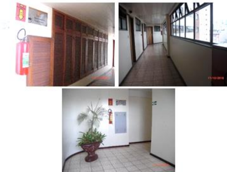
Figura 60-Corredores Solar Flat Hotel. Fonte: arquivo próprio.
