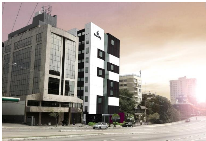
Figura 112- Fachada desenhada em painéis de alumínio. Fonte: Galeria da Arquitetura site, 2016.
