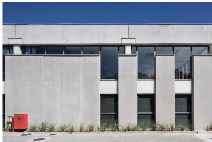
Figura 109 - Estrutura em concreto. Fonte: Galeria da Arquitetura site, 2016.
