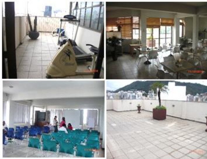
Figura 59- Cobertura Solar Flat Hotel. Fonte: arquivo próprio.
