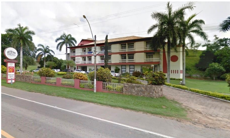
Figura 62 - Fachada frontal recuada- Caiçara Hotel e Eventos. Fonte: Google Maps.
