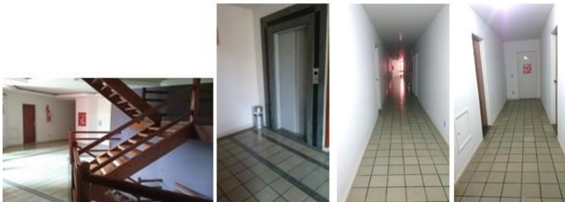
Figura 72 - Escada elevadores corredores amplos. Fonte: arquivo próprio.
