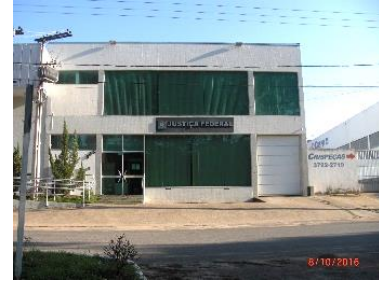
Figura 32 - Fórum da Justiça Federal. Fonte: arquivo próprio.
