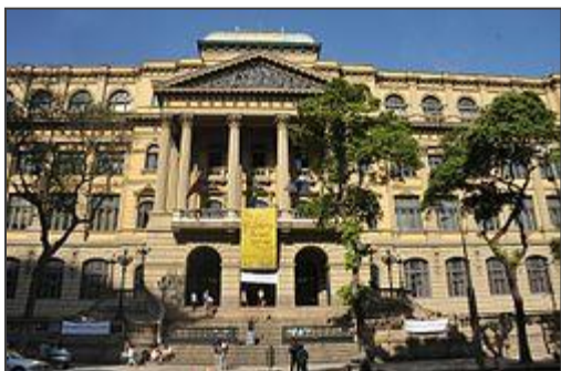
Fig 2: Fachada em estilo eclético projetado por Sousa Aguiar Imagem: Ricardo Figueira
