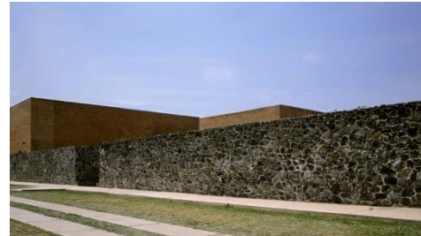
Vista externa. Parede cega de 100 metros Fonte: Plataforma Arquitectura
