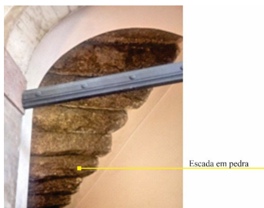
Figura 45: Escada em pedra, construção inicial. Fonte: Acervo da autora, 2019.
