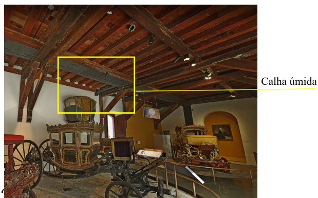
Figura 41: Adaptações feitas no edifício para instalação de cabeamento e iluminação. Fonte: Acervo da autora, 2019.
