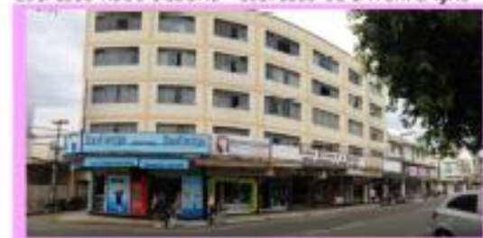
EDIFÍCIO ABDO BUSSAD - EDIFÍCIO DE INTERVENÇÃO
