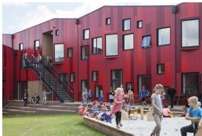
Figura 24 - Área externa da escola
