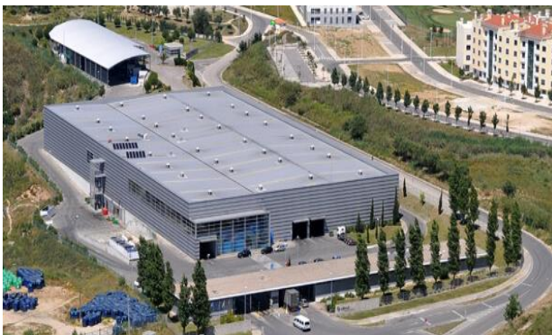
Figura 31- centro de triagem de Lumiar
