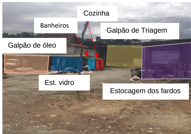
Figura 01: Sede Cooperativa dos Catadores de Itaperuna
