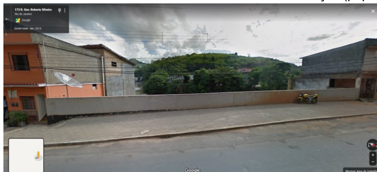
Figura 34 – Trecho de deslizamento no bairro N. S. das Graças (popularmente Pito)
