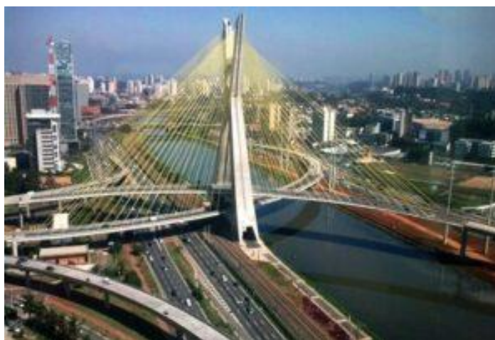
Fig 5 – Ponte em Estaiada.
