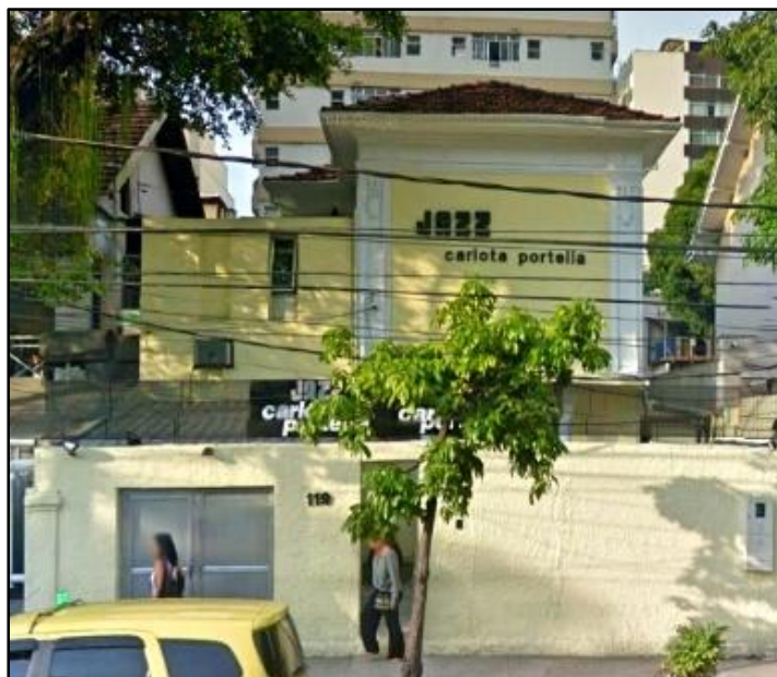
Figura 85: Fachada Fonte: Arquivo pessoal, foto tirada pela autora em 24/10/2016
