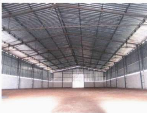
Figura 1: Telhado de duas águas (Fonte: http://rf.demolidora.zip.net/ , 05/2011)
