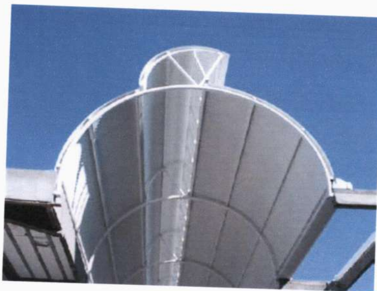
Figura 25: Passarela com telhas calandradas (Fonte: ABCEM, 2009)
