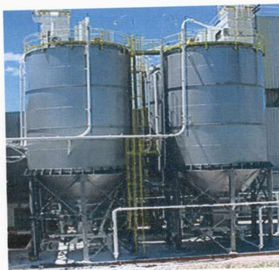
Figura 1: Sistema de transporte pneumático para silos de armazenamento (Fonte: Airetron, 2011)
