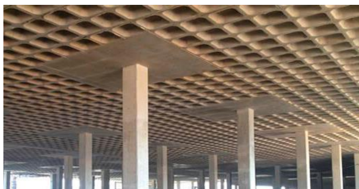
Figura 10 - Capitel em laje nervurada
