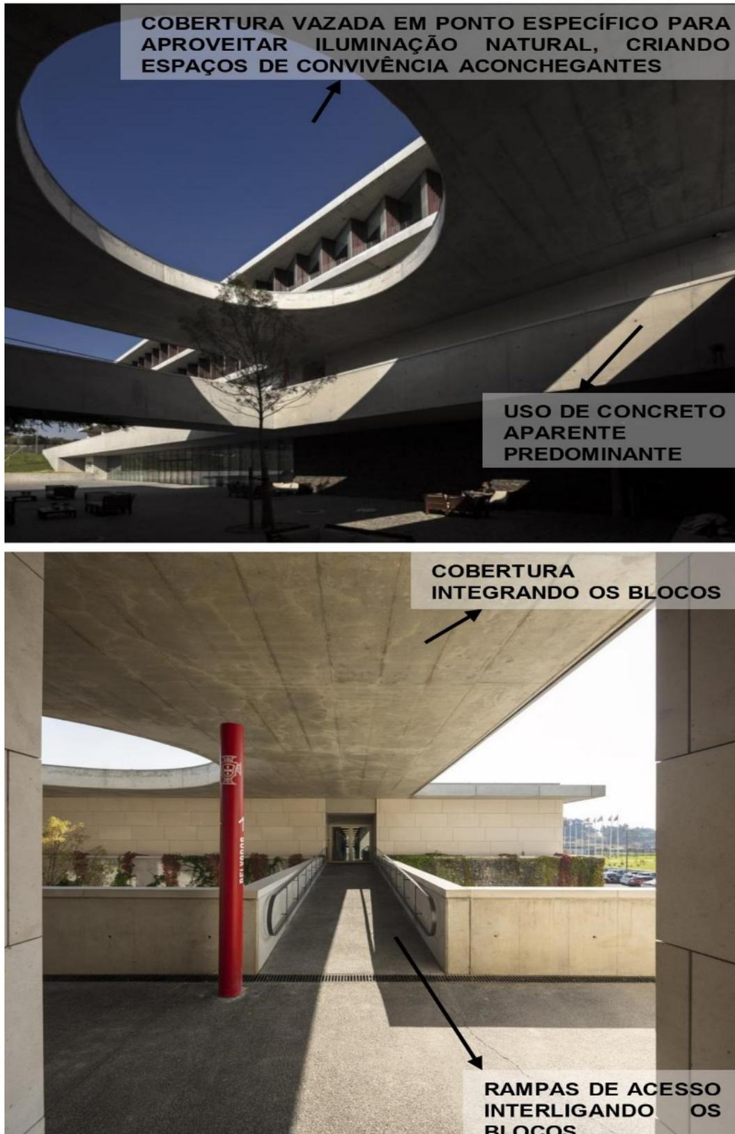
Figura 46– Análise de materiais e elementos construtivos da Cidade do Futebol.
