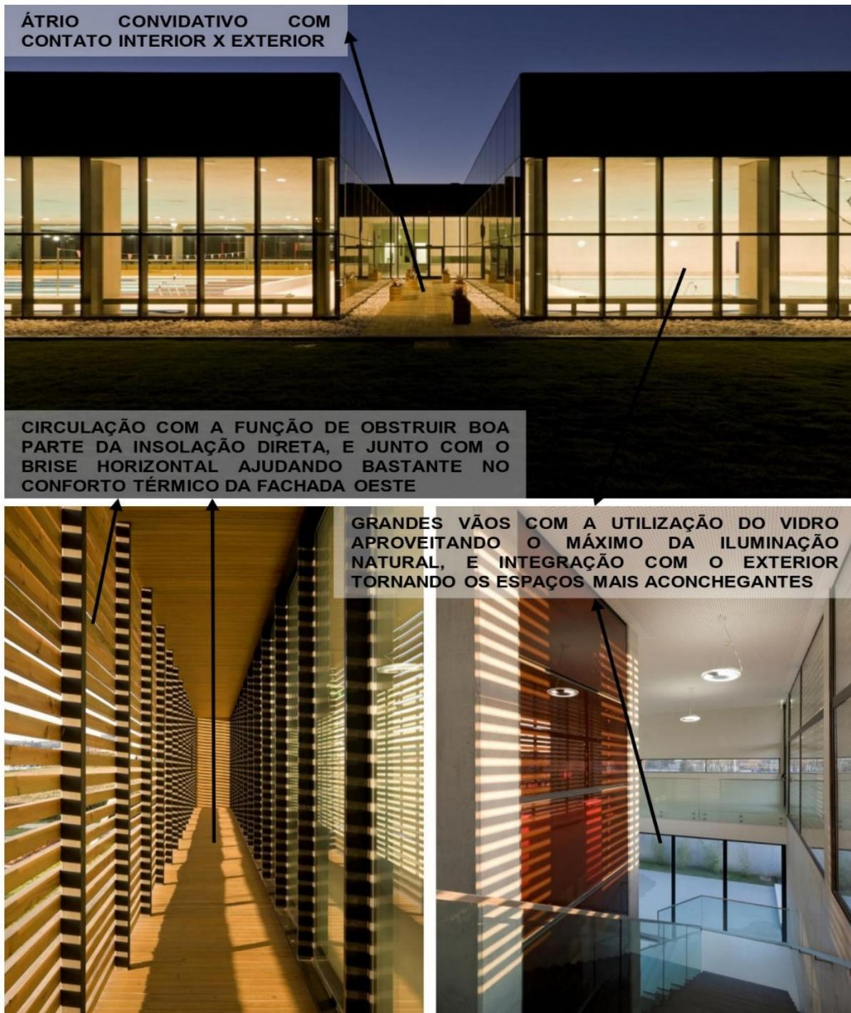
Figura 52 - Análise de materiais e métodos construtivos das Piscinas Municipais de Ribeirão.
