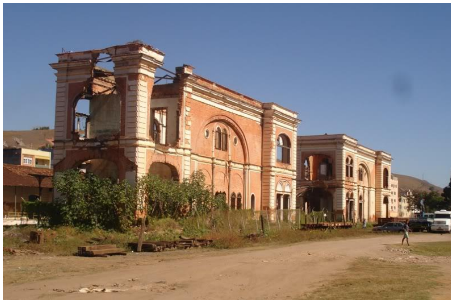
Imagem 3: Estação Ferroviária Porto Novo
