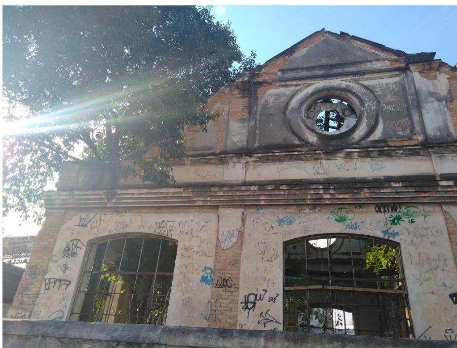
Imagem 11: Construção ao lado não restaurada
