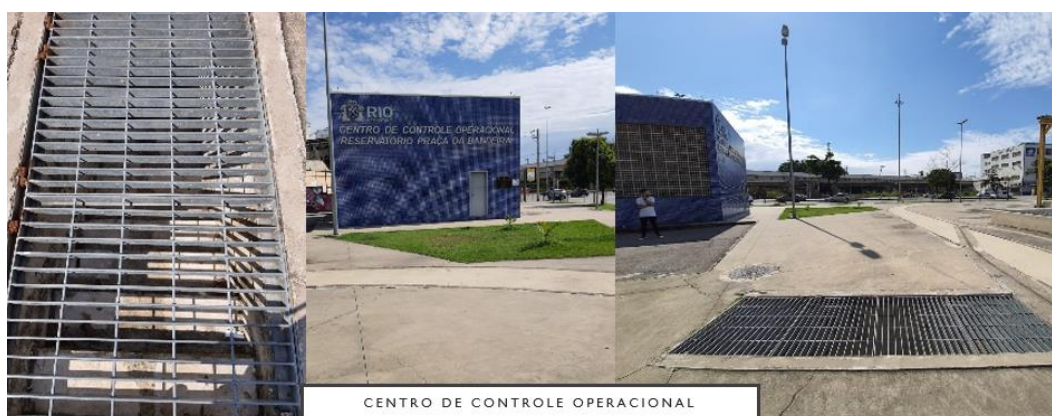
Figura 21: Grelha de captação de água e Centro de controle operacional
