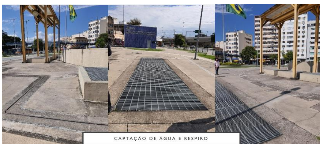
Figura 20: Grelha de captação de água e sistema de respiro
