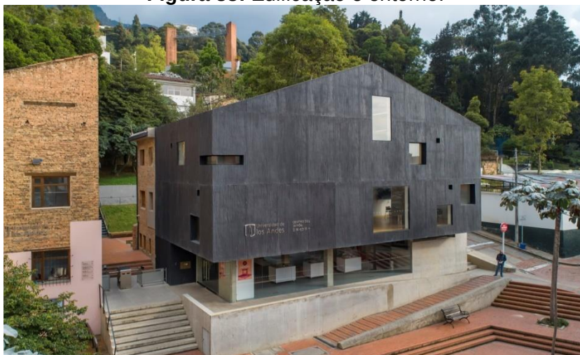
Figura 33: Edificação e entorno.
