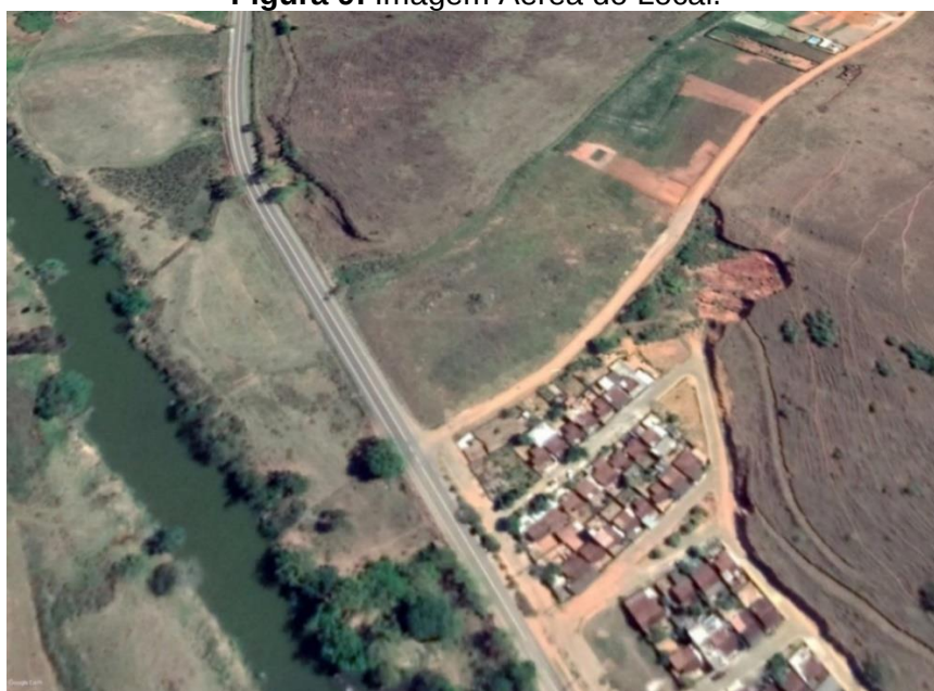
Figura 9: Imagem Aérea do Local.
