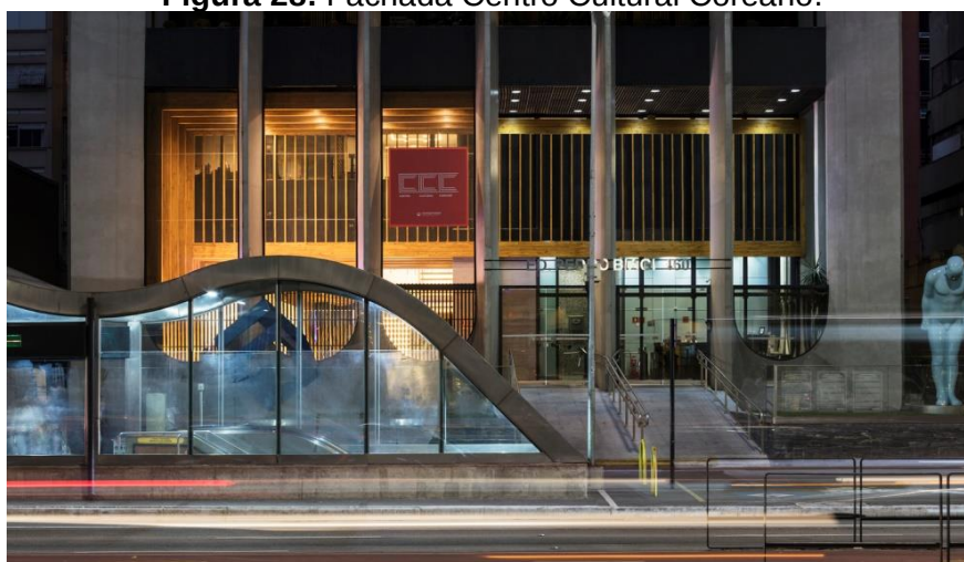
Figura 28: Fachada Centro Cultural Coreano.
