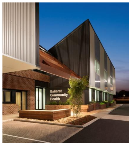
Figura 47: Entrada Centro médico Ballarat. Fonte: Archdaily, site, 2015.
