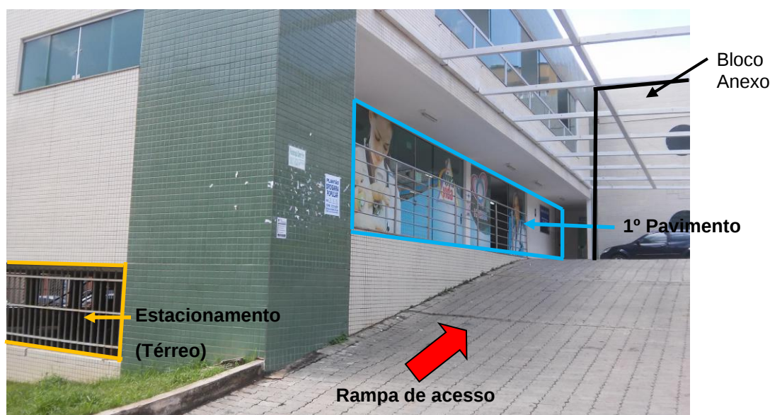
Figura 54: Lateral do Edifício, evidenciando o primeiro pavimento. Fonte: Acervo da autora, 2016.
