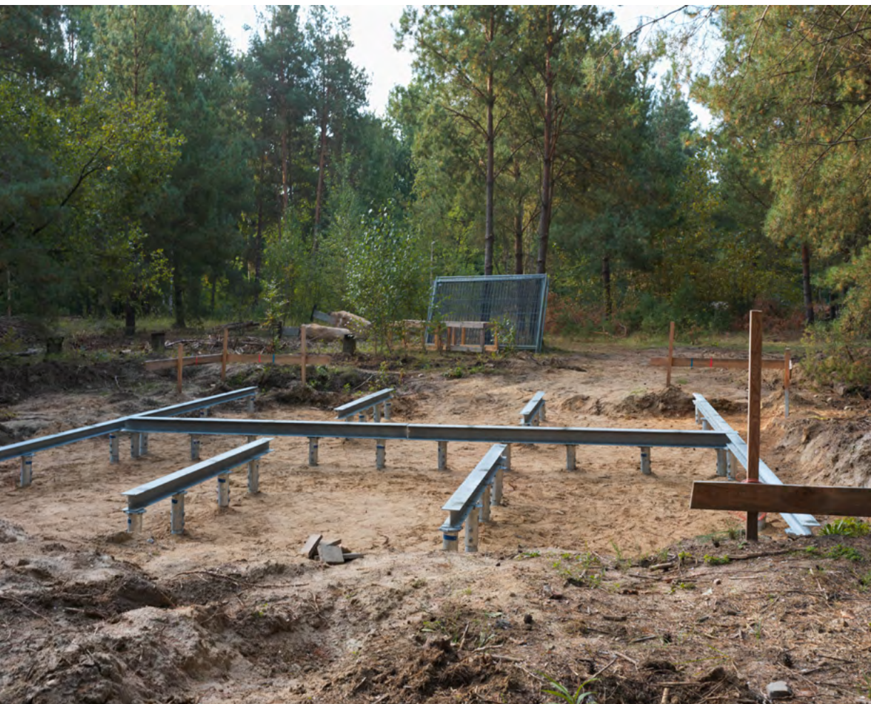
Abb. 4: Schraubfundamente und Unterkonstruktion vom Musterhaus
