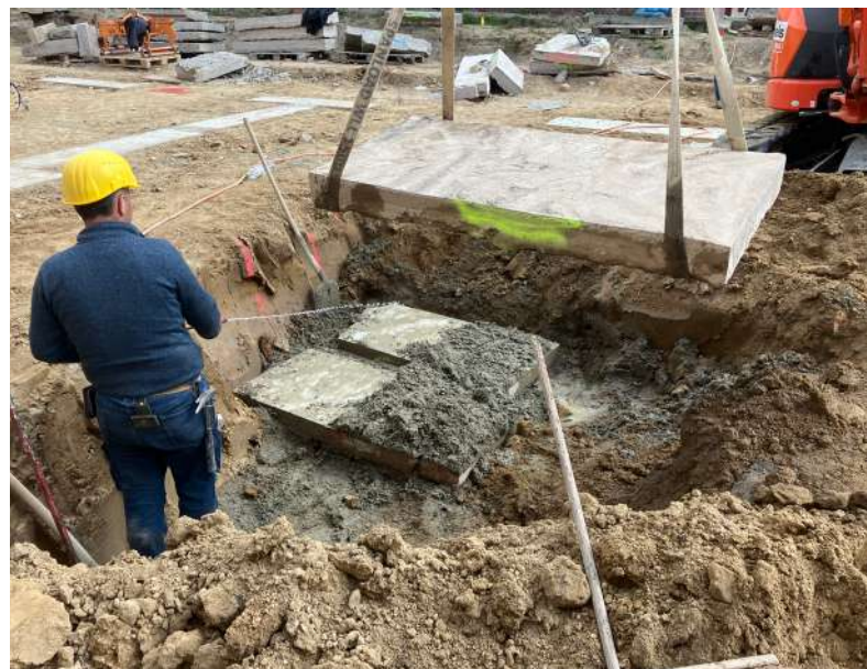
↔ Abb. 21, 22: Gestapelte Betonelemente Fotos: B&O Bau und Gebäudetechnik
