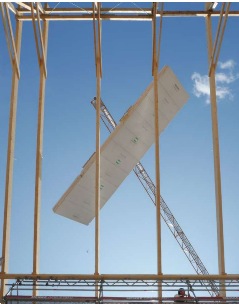
←↓ Abb. 38, 39: Einheben und Positionieren der vorgefertigten Bodenplattenelemente Fotos: B&O Bau und Gebäudetechnik
