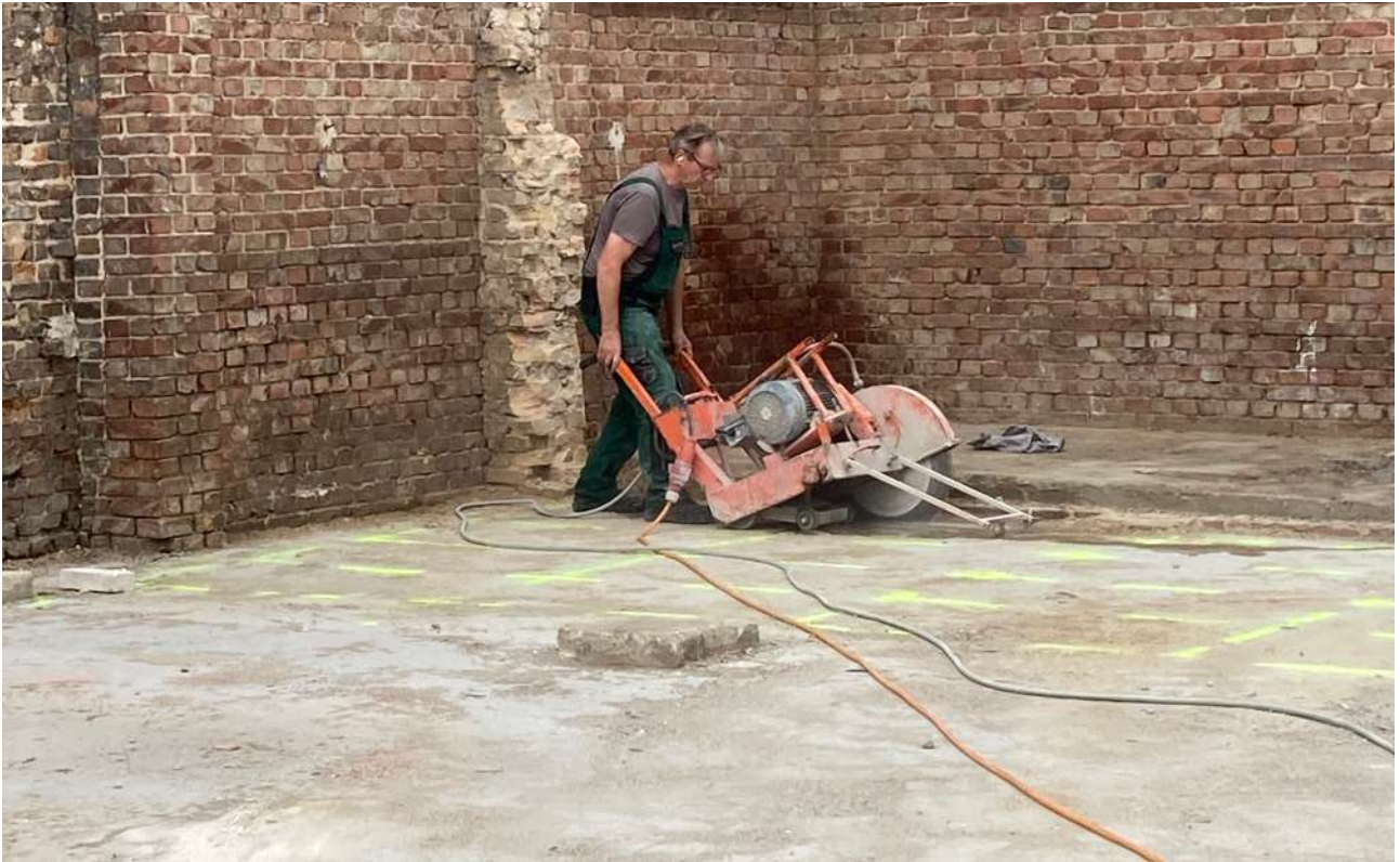
↑ Abb. 23: Zuschnitt Bestandsbodenplatte Foto: B&O Bau und Gebäudetechnik
