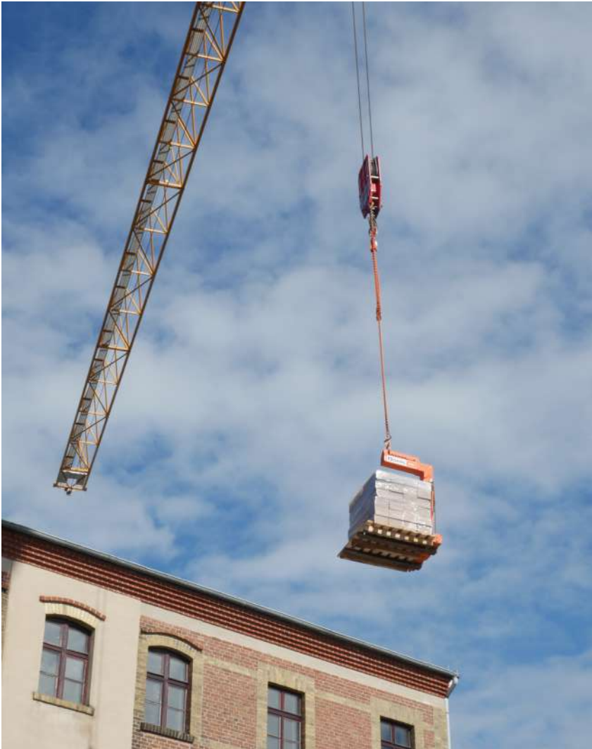
← Abb. 78: Baustellenanlieferung der Lehmeinhangsteine
