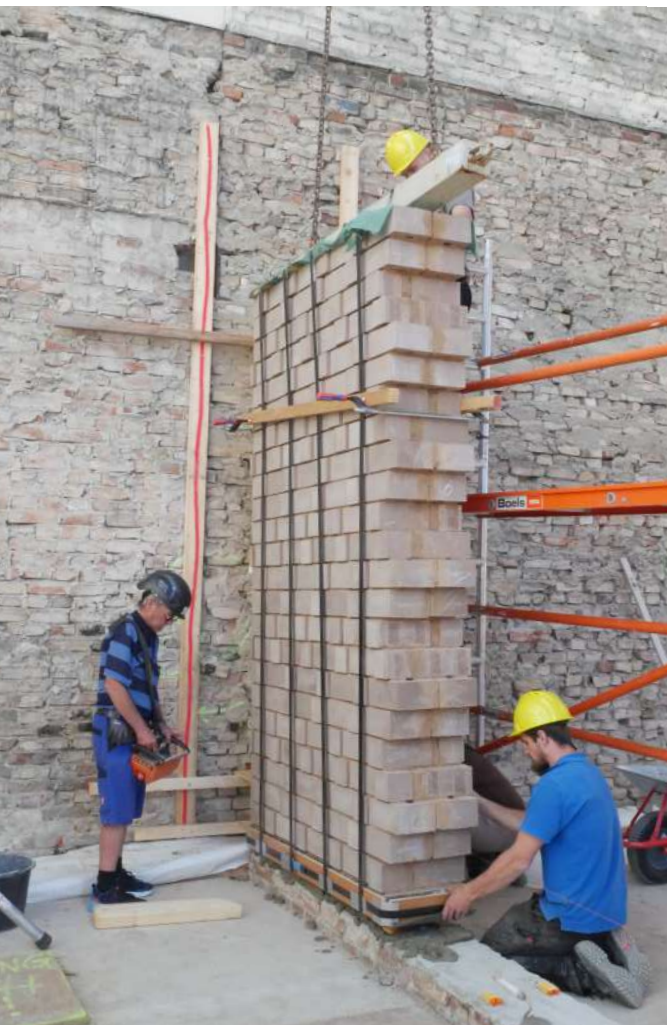
← Abb. 52: Offen verzahnte Stöße der vorgefertigten Lehmsteinmauerwerkselemente Foto: Jan Bitter
