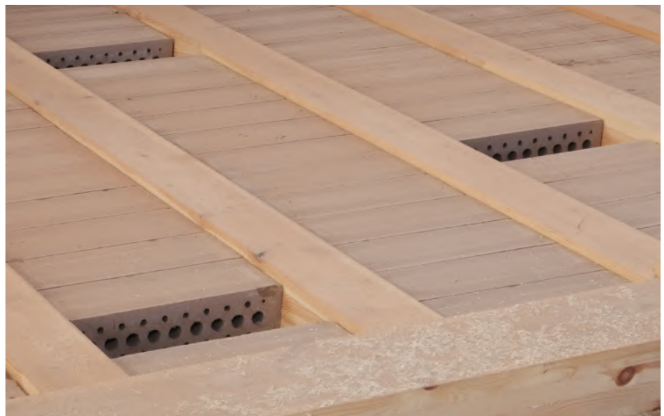
↓ Abb. 79: Holz-Lehm-Hybriddecke Fotos: B&O Bau und Gebäudetechnik
