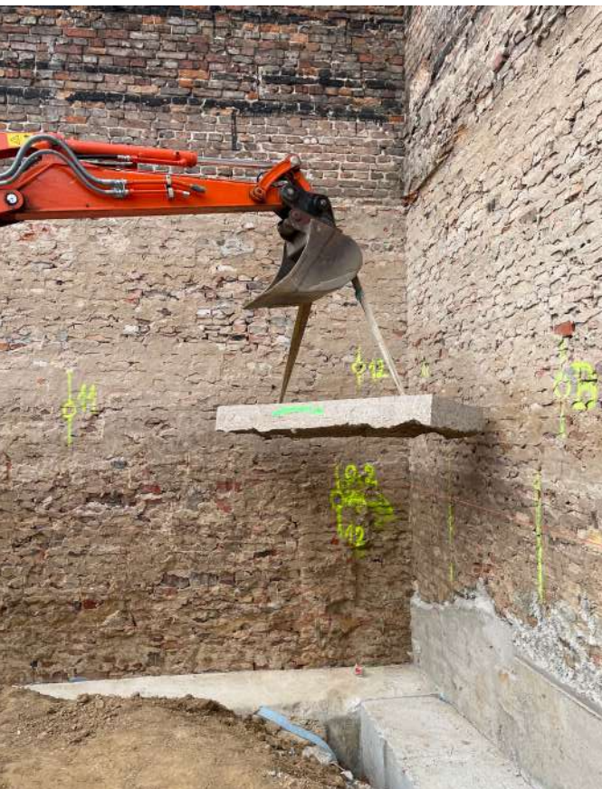
↑ Abb. 23: Zuschnitt Bestandsbodenplatte Foto: B&O Bau und Gebäudetechnik
