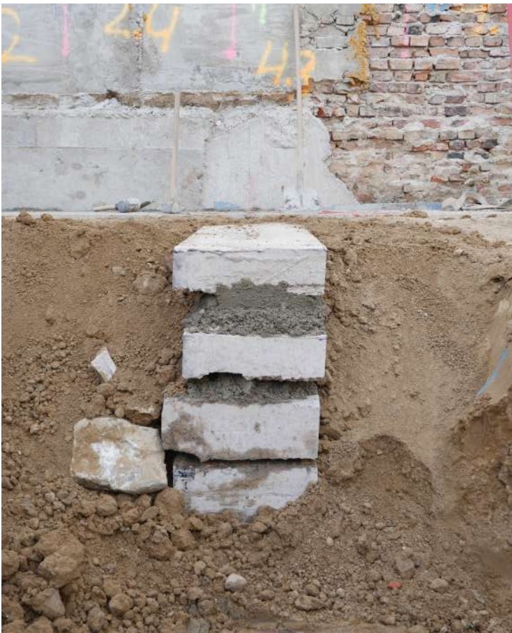
↑ Abb. 26: Fügung zu Stapelfundamenten Foto: B&O Bau und Gebäudetechnik
