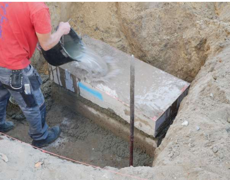
↑ Abb. 20: Gestapelte Betonelemente Foto: B&O Bau und Gebäudetechnik
