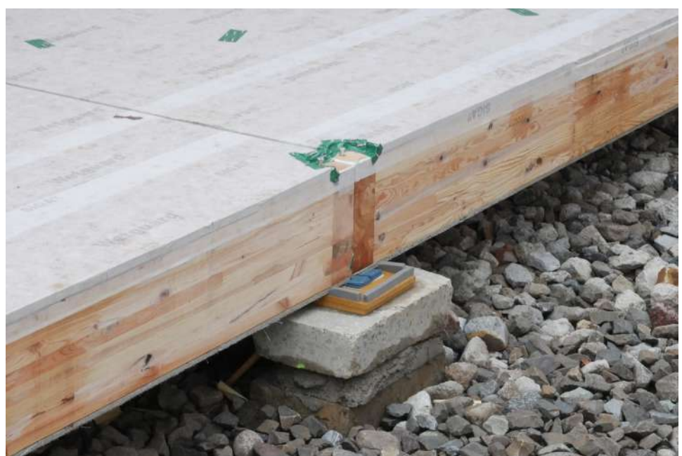
↓ Abb. 41: Bodenplatte auf Fundament Fotos: B&O Bau und Gebäudetechnik
