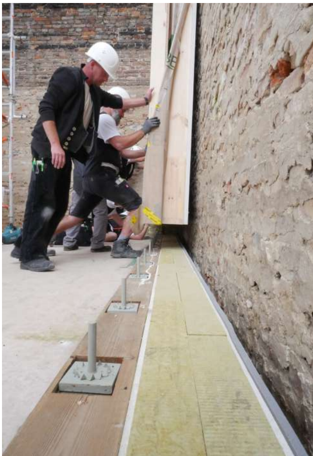
↑ Abb. 65: Metallsteckverbinder auf Rähm
