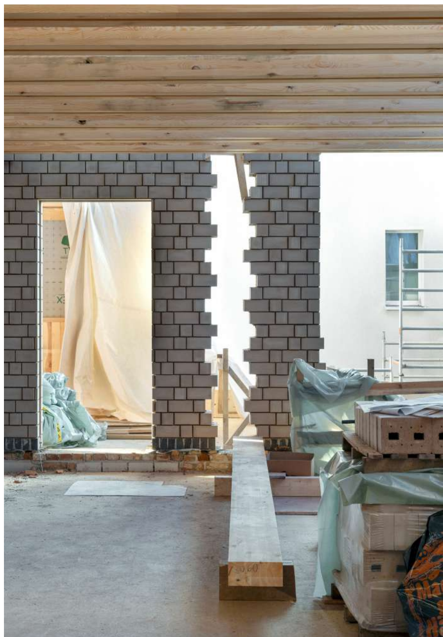
↓ Abb. 53: Einheben und Positionieren der vorgefertigten Lehmsteinmauerwerkselemente Foto: B&O Bau und Gebäudetechnik
