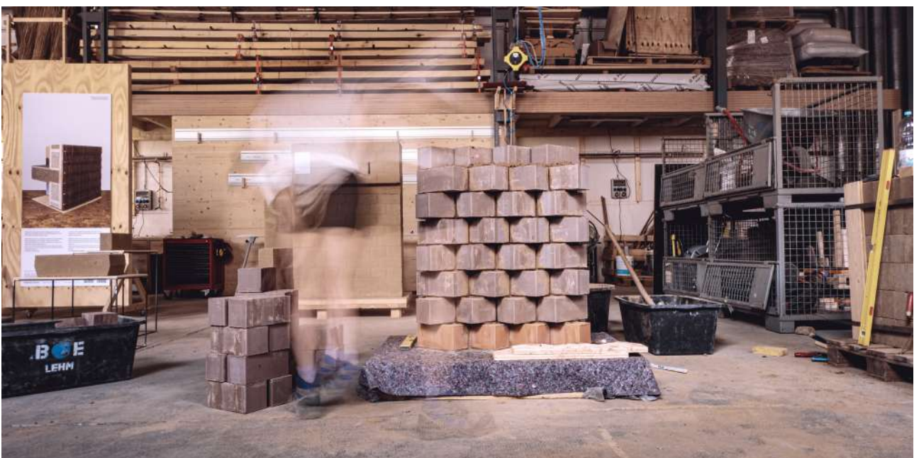
Abb. 80: Herstellung Prototyp 1 Lehmsteinmauerwerk Foto: Bauhaus Erde
