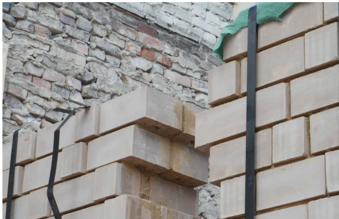
↓ Abb. 51: Offen verzahnte Stöße der vorgefertigten Lehmsteinmauerwerkselemente Fotos: B&O Bau und Gebäudetechnik
