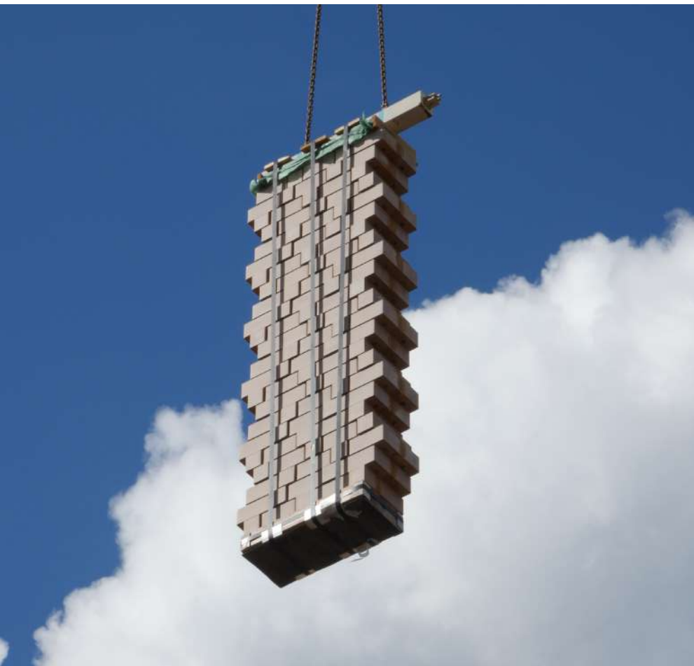
← Abb. 50: Einheben des vorgefertigten Lehmsteinmauerwerks
