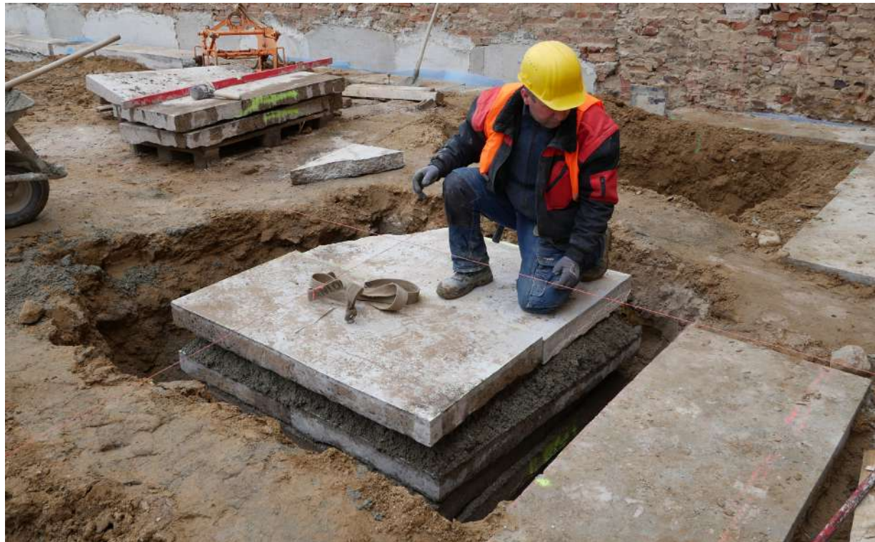
↑ Abb. 26: Fügung zu Stapelfundamenten Foto: B&O Bau und Gebäudetechnik
