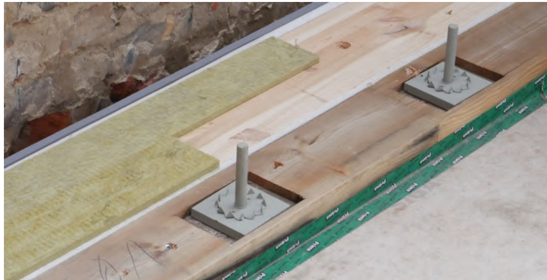
↑ Abb. 65: Metallsteckverbinder auf Rähm
