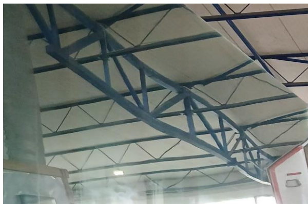
Primer roller wave distorzije. Pojava karakteristična za kaljeno staklo, zavisi od dimenzija i debljine stakla. Izvor: arhiva Konkav-konveks doo Treće izdanje - strana 6
