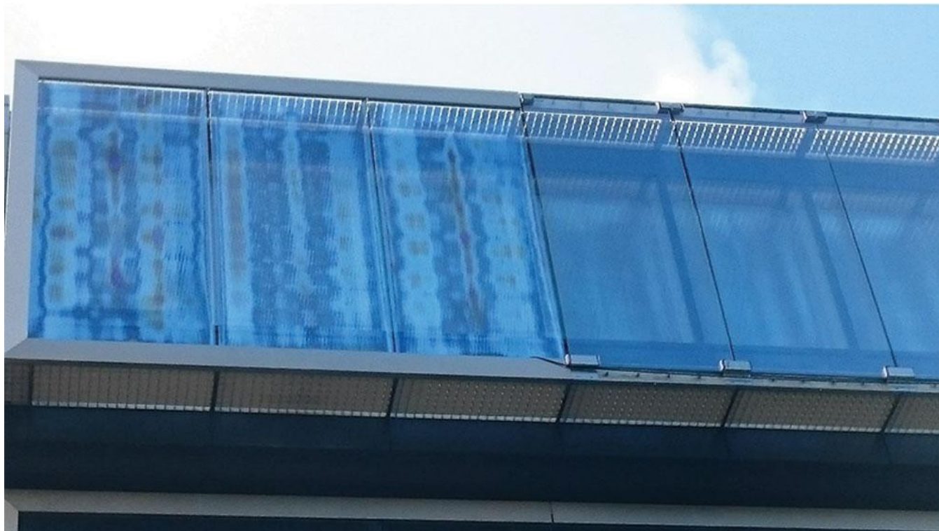
Primer anizotropije. Pojava je karakteristična za termički obrađeno staklo i procenjuje se u propisanim uslovima posmatranja Izvor: glassinspector.com
