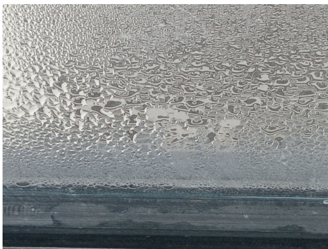
Poređenje kondenzacije i zamagljenja unutar međuprostora. Samo pojava u hermetički zatvorenom međuprostoru može ukazivati na gubitak zaptivenosti. Izvor: arhiva Konkav-konveks doo
