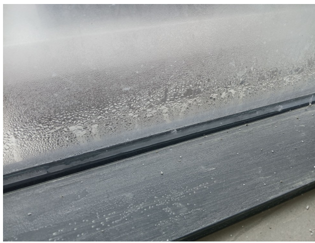
Poređenje kondenzacije i zamagljenja unutar međuprostora. Samo pojava u hermetički zatvorenom međuprostoru može ukazivati na gubitak zaptivenosti. Izvor: arhiva Konkav-konveks doo
