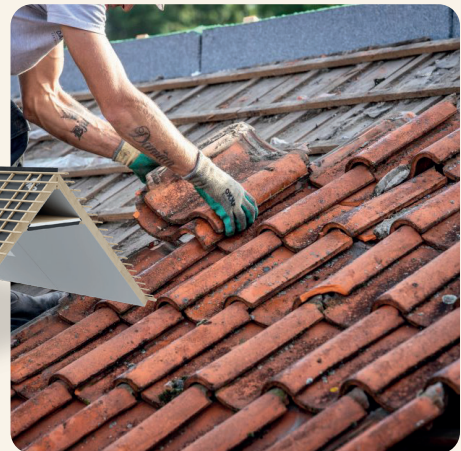
Hergebruik van dakpannen
