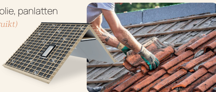
Hergebruik van dakpannen
