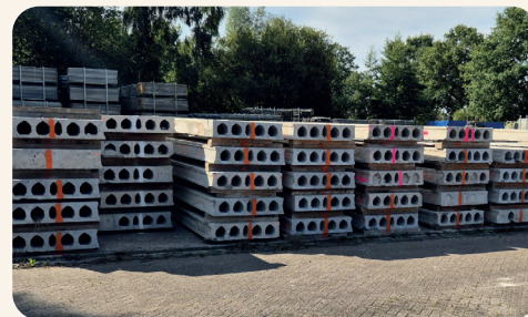
Hergebruikte geïsoleerde kanaalplaatvloeren
