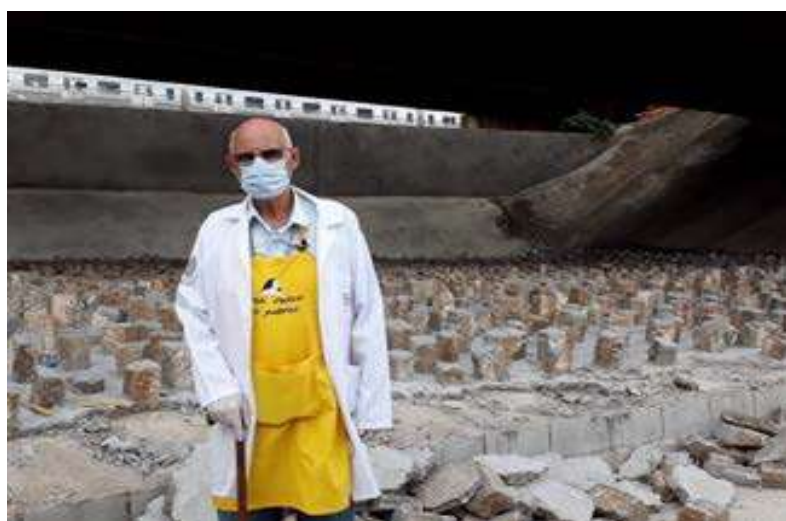
Figura 4. Viaduto Dom Luciano Mendes de Almeida , em São Paulo (SP). Estrutura com pedras instaladas para evitar ocupação por pessoas em situação de rua, gerando rejeição e desumanização do espaço (FAVERO, 2021).
