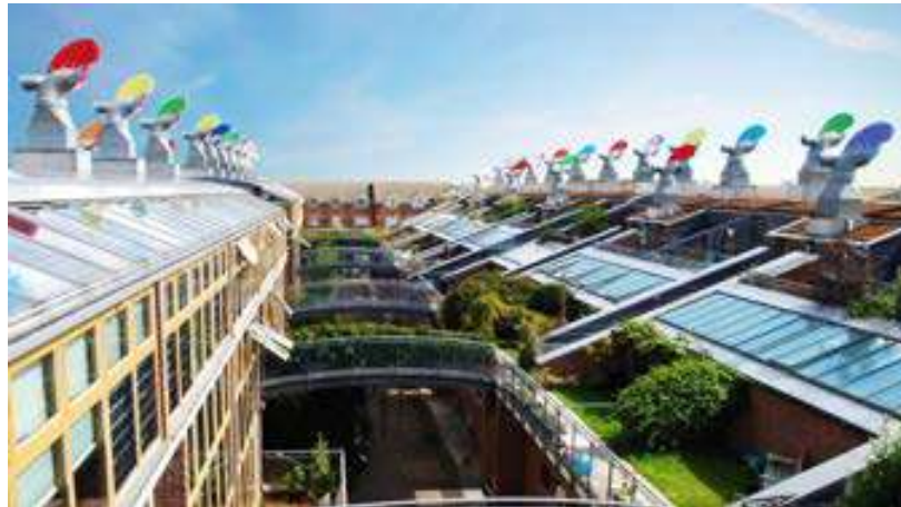
Figura 01 – Parte superior dos edifícios com tecnologias de energias renováveis. Fonte: ZedFactory
