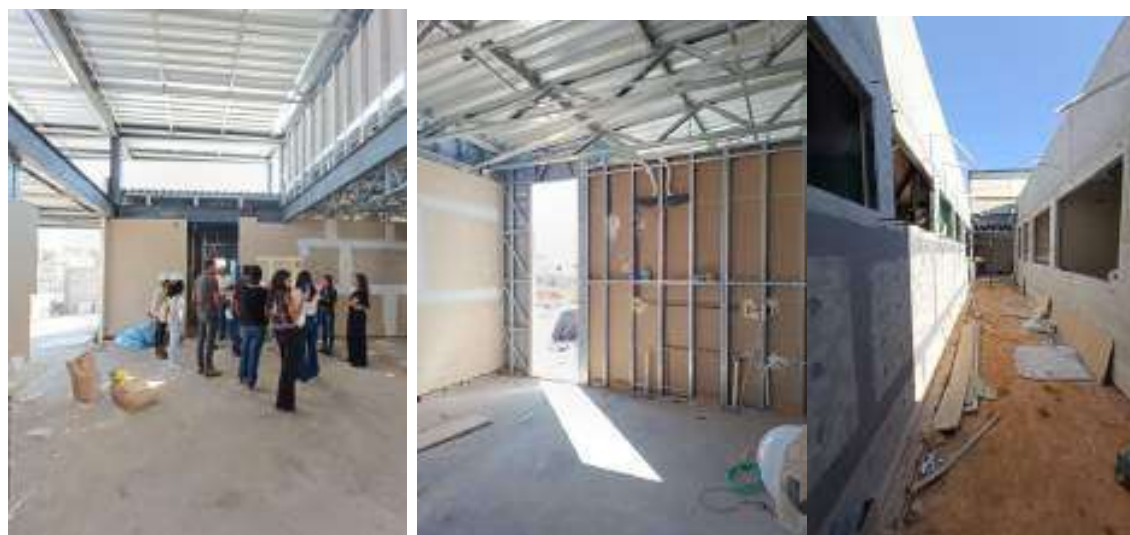
Figuras 3, 4, 5 e 6 - Visita técnica à construção de Unidade Básica de Saúde – Vila Anália. Fonte: Acadêmica/autora – Gely Alissandre Fernandes
