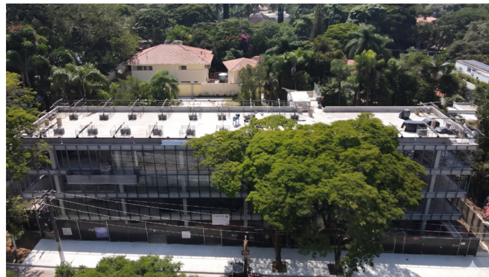
FOTO DA OBRA
