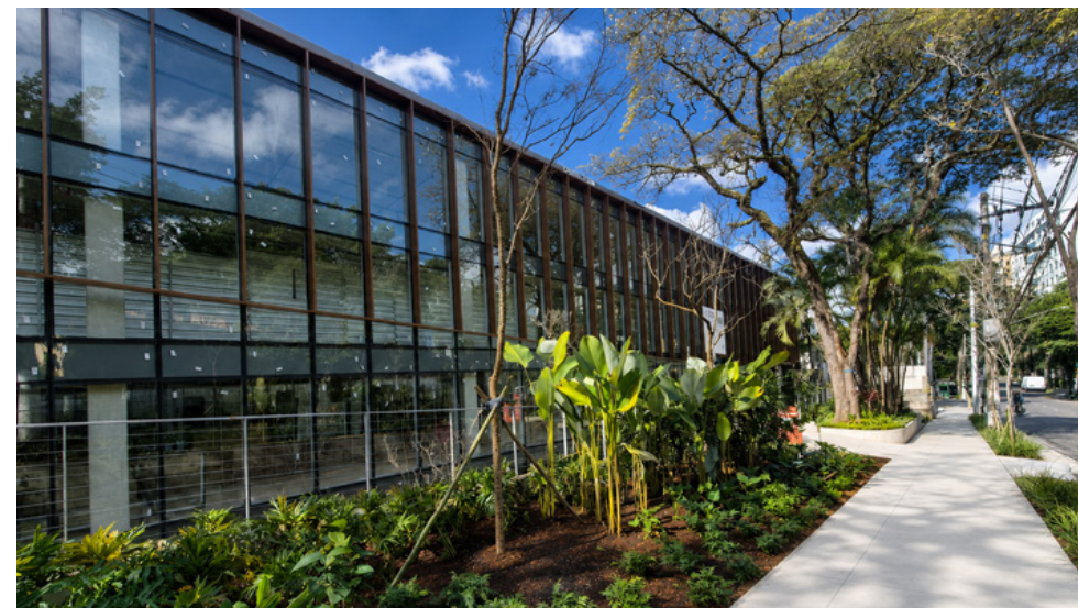
FOTO DA OBRA
