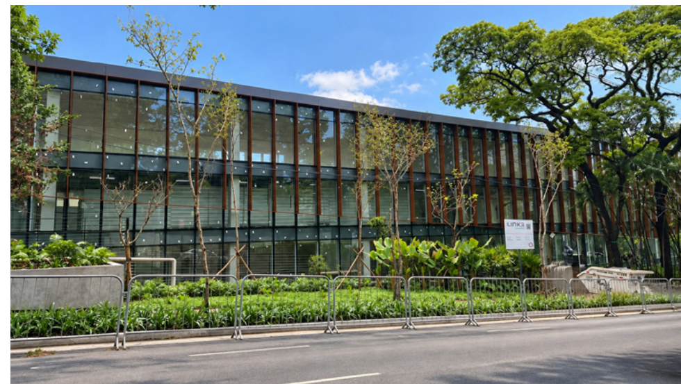
FOTO DA OBRA
